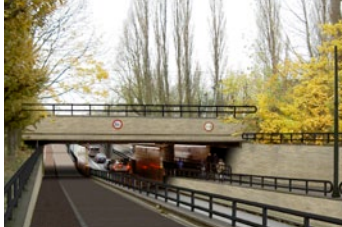
Spoortunnel Gouda, renovatie van de tunnel en herinrichting van de openbare ruimte. Maart 2014
