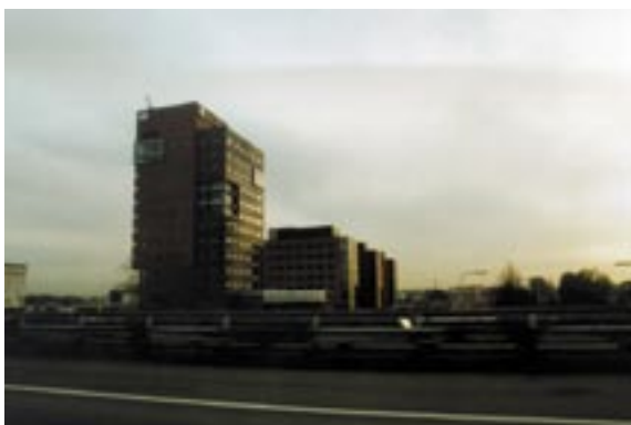
Utrecht: De gebouwen vormen een ensemble, niet langs de snelweg maar in de diepte.
